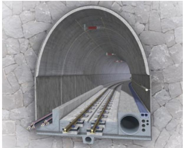
Abb. 2: Variante für die Parallelführung: Kabel in gebündelter Verlegung, Leitmauer, Schiene, Fluchtweg und Lüftungsrohr für Personenschutzräume (v. l.).
